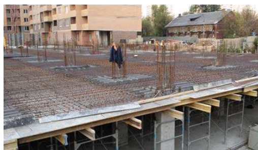
Рис. 2. Перекрытие перед бетонированием
